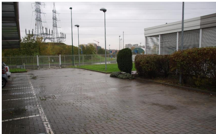
Foto 1: unità 1. Area a parcheggio sopraelevata nei pressi dell'ingresso. Vista da Sud.
